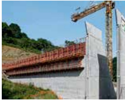
Lurberria Dam, St Pée Sur Nivelles, France
