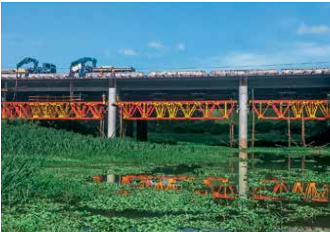
Ponte Rio do Salto, Brazil
